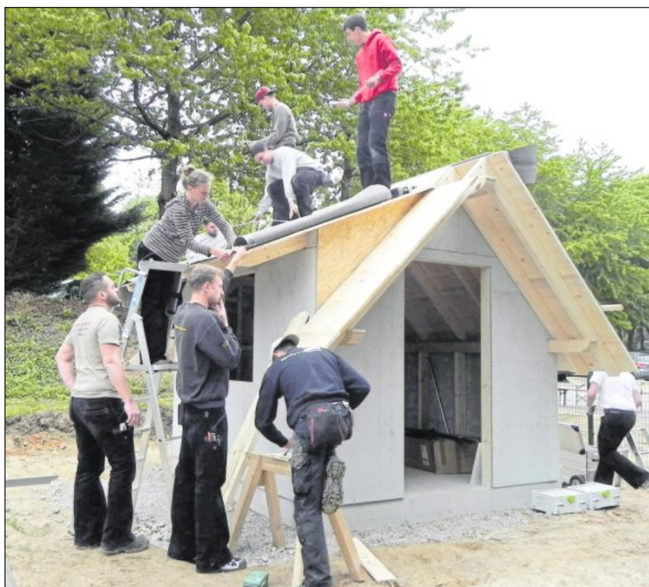
ES WIRD KRÄFTIG GEBAUT: Zimmerer-Azubis des Kompetenzzentrums der Bauwirtschaft Bühl haben die Hütte gebaut. Foto: jfr
