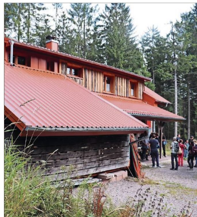
Lange verschoben, endlich wahr: Das Dach der Skihütte Ottersweier ist erneuert worden. Foto: Franz Vollmer
