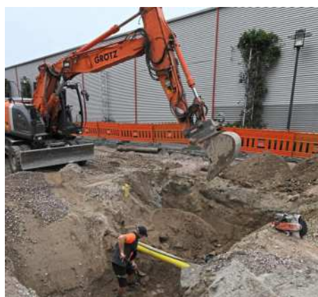
So ist es richtig: Dieser Bauarbeiter arbeitet mit der Schaufel an einer Gashochdruckleitung.
